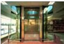
Лифт MAISON актуален для помещений, где строительная инфраструктура не позволяет установить лифт стандартных габаритов. Это укомплектованный лифт, поставляемый с металлокаркасной шахтой. Лифт прост в монтаже и может устанавливаться как снаружи здания, так и внутри него. Лифт MAISON не требует специального пространства для машинного помещения и подготовленной бетонной либо кирпичной шахты.
